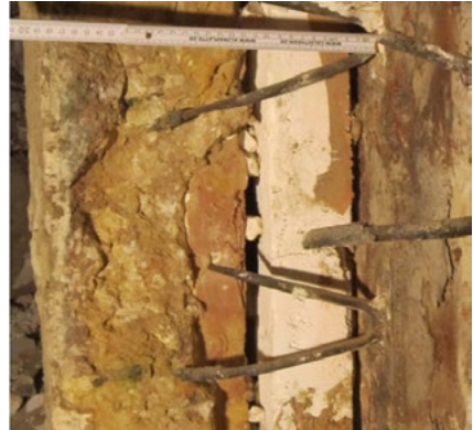
Abbildung 9: Querschnitt der Einlaufkammerwand nach zweijähriger Laufzeit, von links nach rechts (heiß nach kalt): brauner Feuerbeton, weiße SILCAL 1100-Wärmedämmschicht, dunkelbraune Ofenaußen-Blechwand mit angeschweißten Stahlankern
